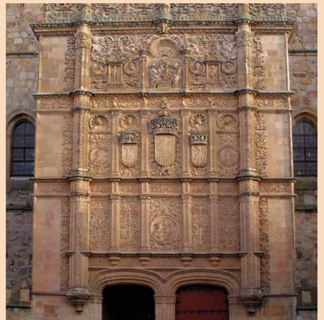
Fig.1. Fachada principal del edificio histórico de la Universidad de Salamanca.
